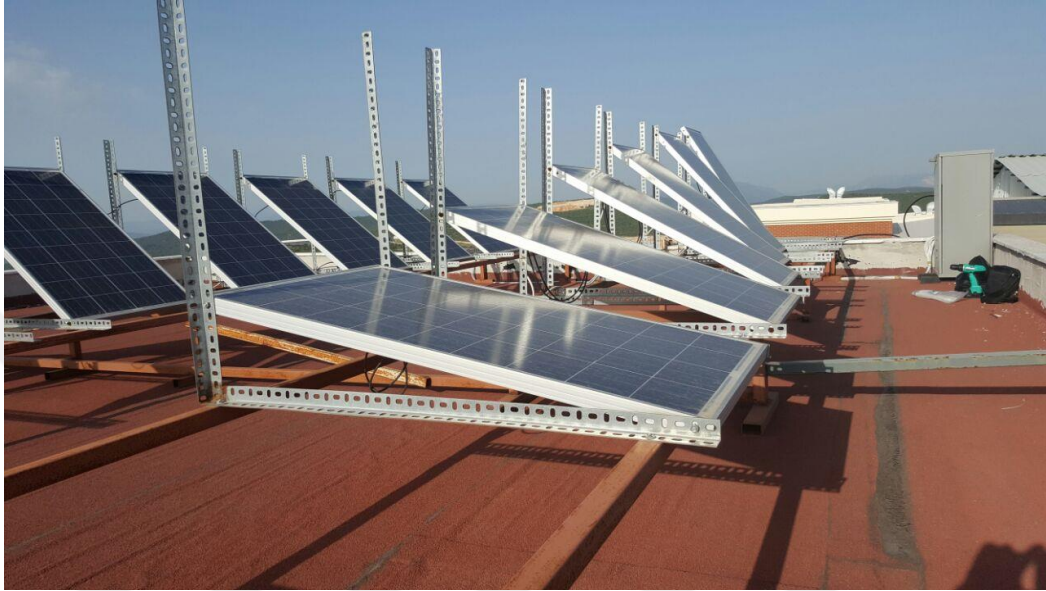
Şekil 4.21. Farklı eğim açılarındaki panellerin kurulum düzeneği.
