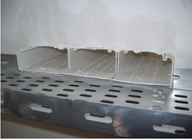
Sistem odası dış duvarı
