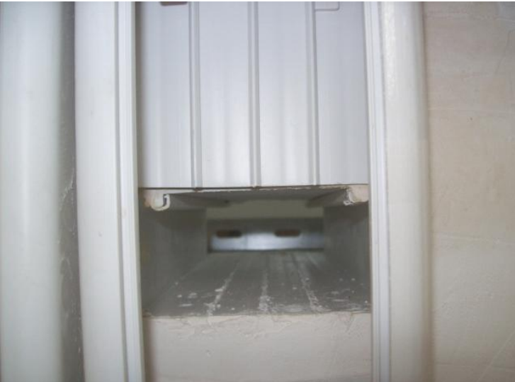
Sistem odası iç duvarı
